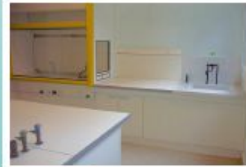
RÉNOVATION DE TABLES DE LABORATOIRE RÉALISÉES EN MAÇONNERIE
